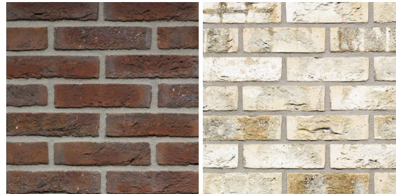
Metselstenen Breevaart Noord (rechter gebouw vanaf de Bodegraafsestraatweg)
