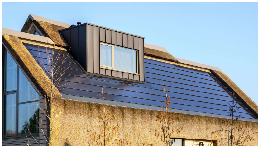
Referentie geïntegreerde W-volt X-roof zonnepanelen
